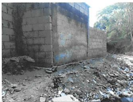
Foto 5: Drenaje para cocina
