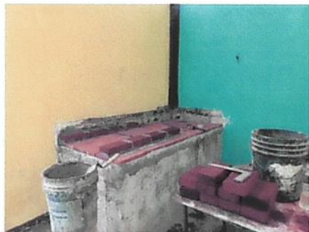
Foto 7: Construcción de estufa artesanal de leña
