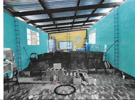
Foto 2: Demolición y construcción de pared para dividir aula
