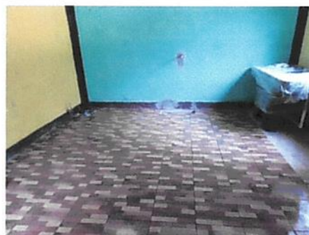
Foto 10: Instalación para pila de cocina
