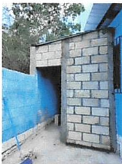
Foto 9: Instalación puerta de metal para bodega/pared
