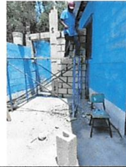
Foto 4: Instalación techo de bodega/pared
