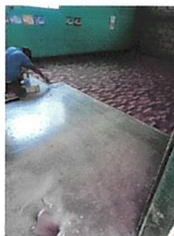
Foto 8: Sustitución piso de cerámica
