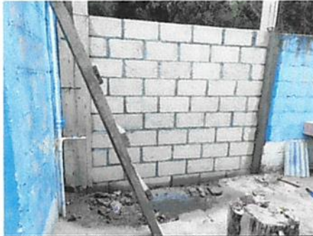
Foto 1: Demolición y construcción del muro perimetral
