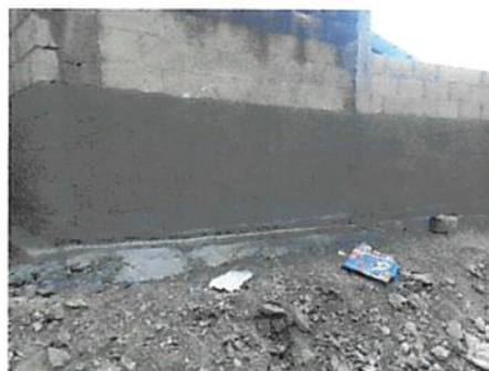
Foto 2: Recubrimiento y repello de muro perimetral
