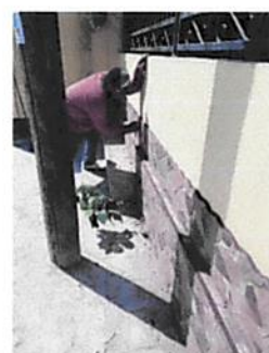
Foto 6: Instalación de piso cerámico (fachaleta)
