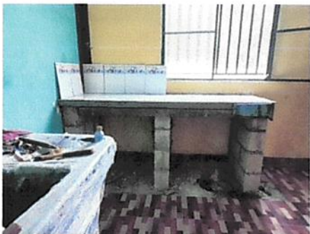
Foto1: Construcción de mesa de cemento para la cocina
