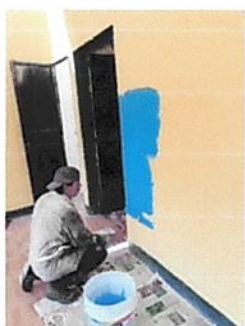
Foto 5: Pintura interior y exterior de la escuela
